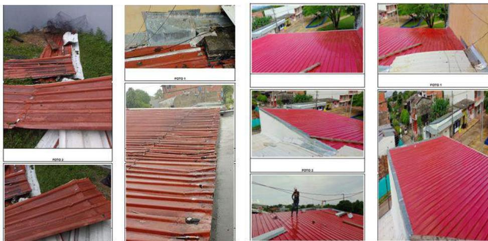
*Ilustración 179 Cambio de cubierta a la sala de eventos en las instalaciones de la oficina de la Cámara de Comercio de Casanare seccional Villanueva*
